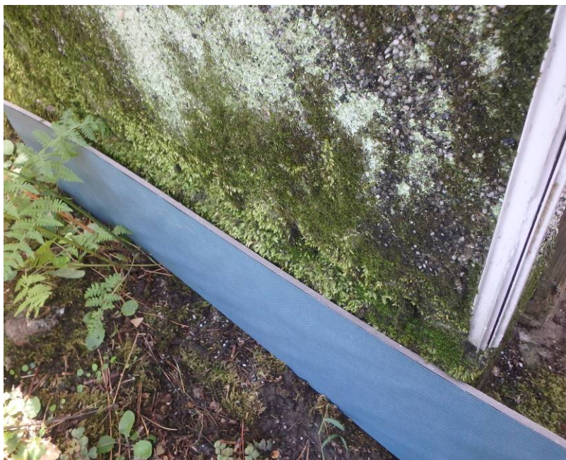
根を制御できる土留め材 “くるくるストップボード” を建物壁の保護に施工
