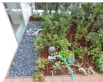
建物壁の保護に施工
